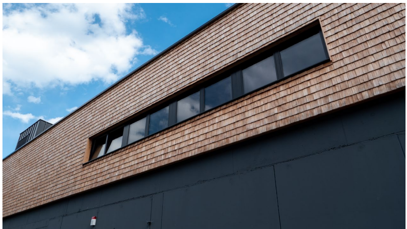
Figure 2: Es wurden 70 Dreh-Kipp-Fenster der Serie HUECK Lambda WS 075 kombiniert mit HUECK Gen 4.0 Beschlägen verbaut (source: HUECK)
